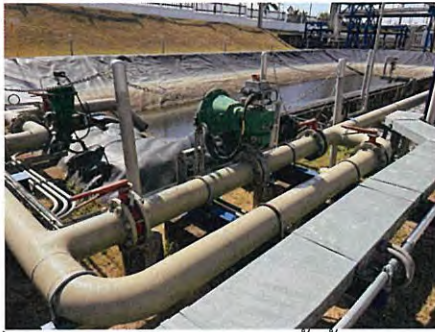
ภาพที่ 2-19 วาล์วควบคุมการปล่อยน้ำทิ้งจากหอหล่อเย็น
