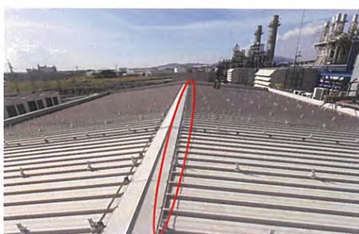
ภาพที่ 2-65 สาย Life Line บริเวณหลังคาอาคาร
