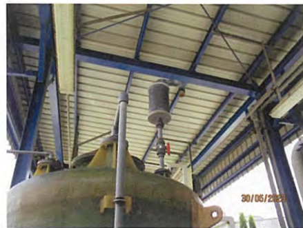
ภาพที่ 2-58 Activated carbon บริเวณถังเก็บสารเคมี
