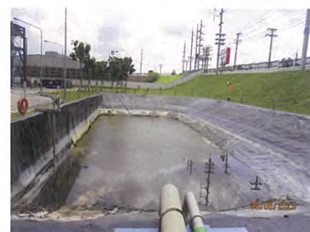
ภาพที่ 2-18 บ่อพักน้ำหล่อเย็น กรณีฉุกเฉิน
