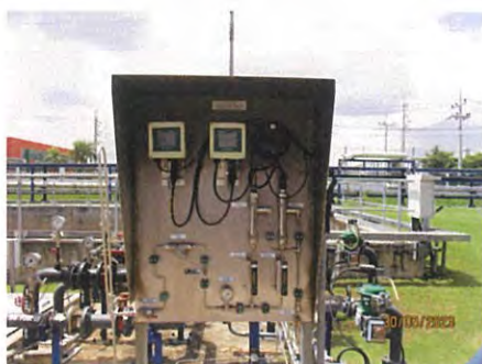
ภาพที่ 2-15 ระบบ Online Monitoring บริเวณบ่อพักน้ำทิ้งรวม
