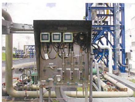
ภาพที่ 2-17 ระบบ Online Monitoring บริเวณบ่อพักน้ำหล่อเย็น
