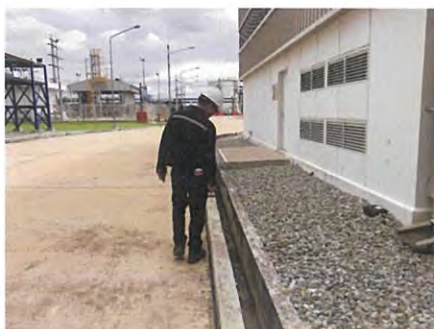
ภาพที่ 2-30 การตรวจสอบรางระบายน้ำฝนในพื้นที่โครงการ
