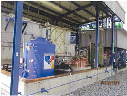
ภาพที่ 2-57 คั่นกันสารเคมีทกรั่วไหล
