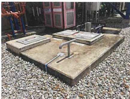
ภาพที่ 2-28 (ต่อ) บ่อรองรับน้ำฝนปนเปื้อน
