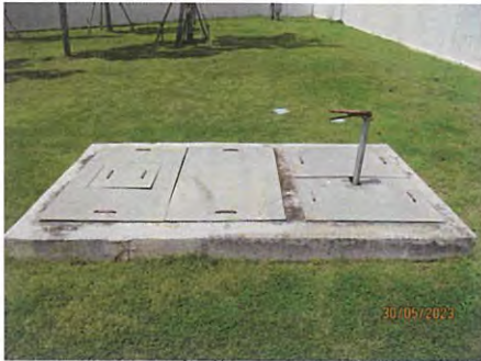
ภาพที่ 2-11 จุดระบายน้ำทิ้งจากบ่อพักน้ำทิ้งรวมไปยังระบบ บำบัดน้ำเสียส่วนกลางของนิคมฯ
