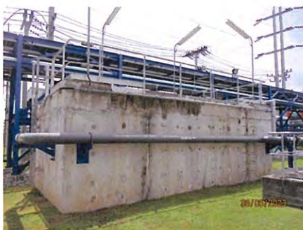
ภาพที่ 2-9 บ่อแยกน้ำ/น้ำมัน (Oil Separator)
